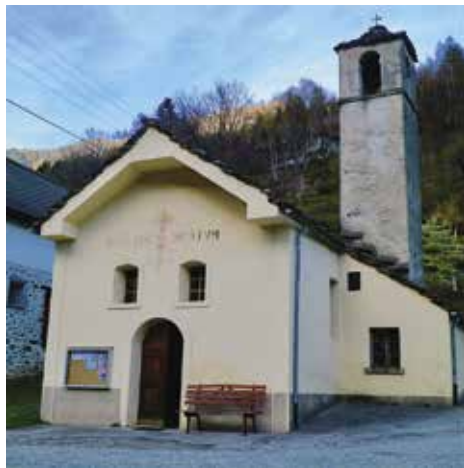
Prima dei lavori
