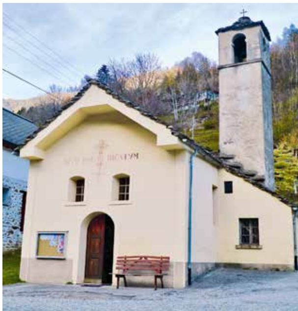
Chiesa prima del restauro
