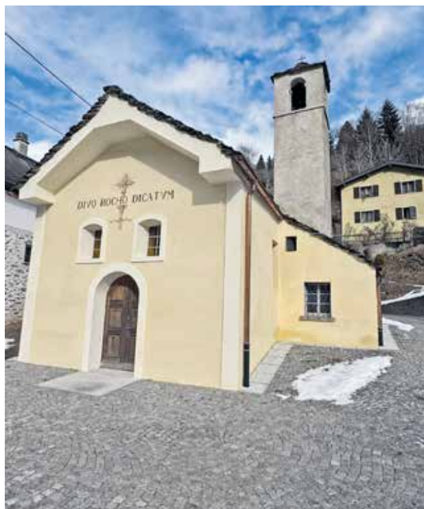
Chiesa a restauri ultimati
